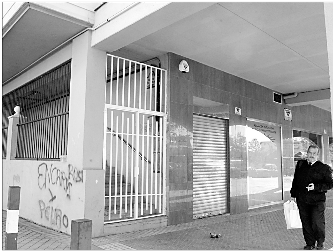
Condena. Edificio Los Girasoles, donde falleció un hombre al caer por el hueco del ascensor. M. Á. M.
