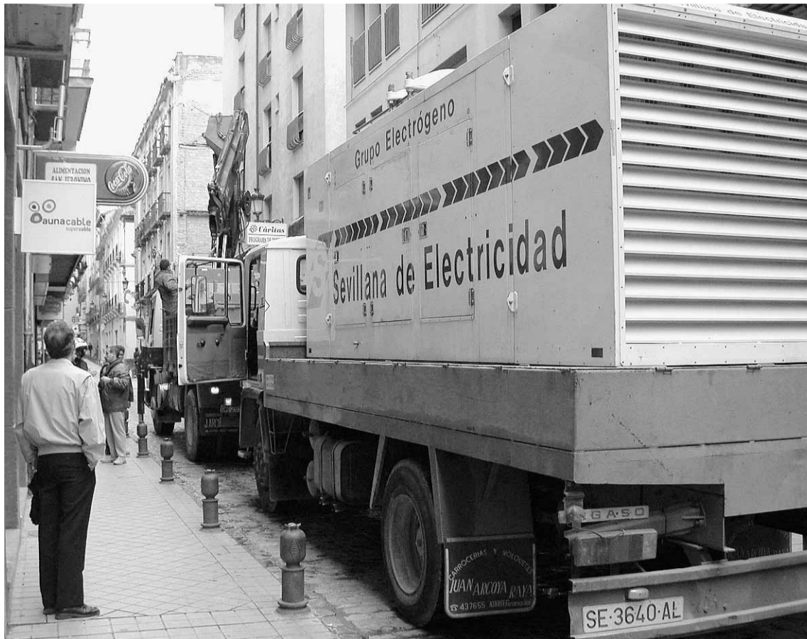
Técnicos arreglan una avería en San Juan de Dios que dejó sin luz a gran parte del centro en 2003. /IDEAL
