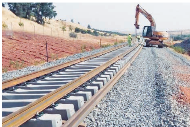
En las imágenes superiores, obras ferroviarias realizadas con traviesas de hormigón fabricadas por Antrasa.
